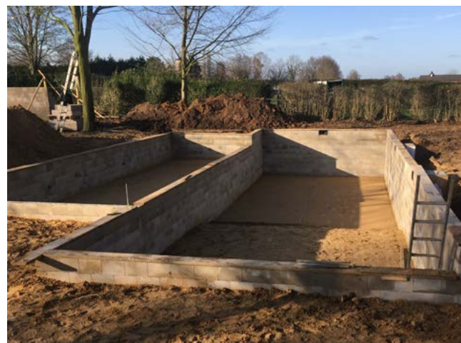
© BT Hoveniers - Bouwkundige zwembijveraanleg gebeurt met 'centimeter-precisie'
