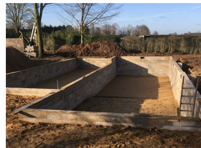
© BT Hoveniers - L'aménagement d'un étang de baignade nécessite une précision au centimètre près
