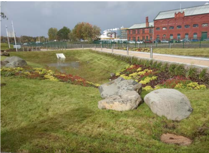
© NatureScot - Les SUDS constituent une nouvelle approche de la gestion de l'eau qui présente de nombreux avantages par rapport aux systèmes conventionnels
