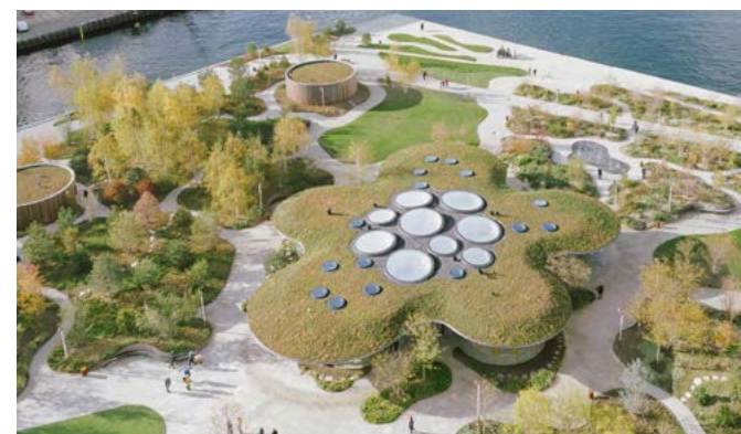
De groene daken zijn specifiek ontworpen om regenwater op te vangen
