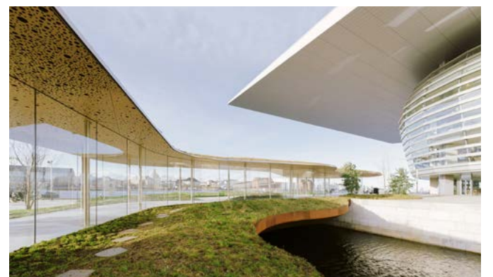
Bezoekers van het park kunnen via een aangelegde brug met een overdekte loopbrug naar de Koninklijke Deense Opera lopen
