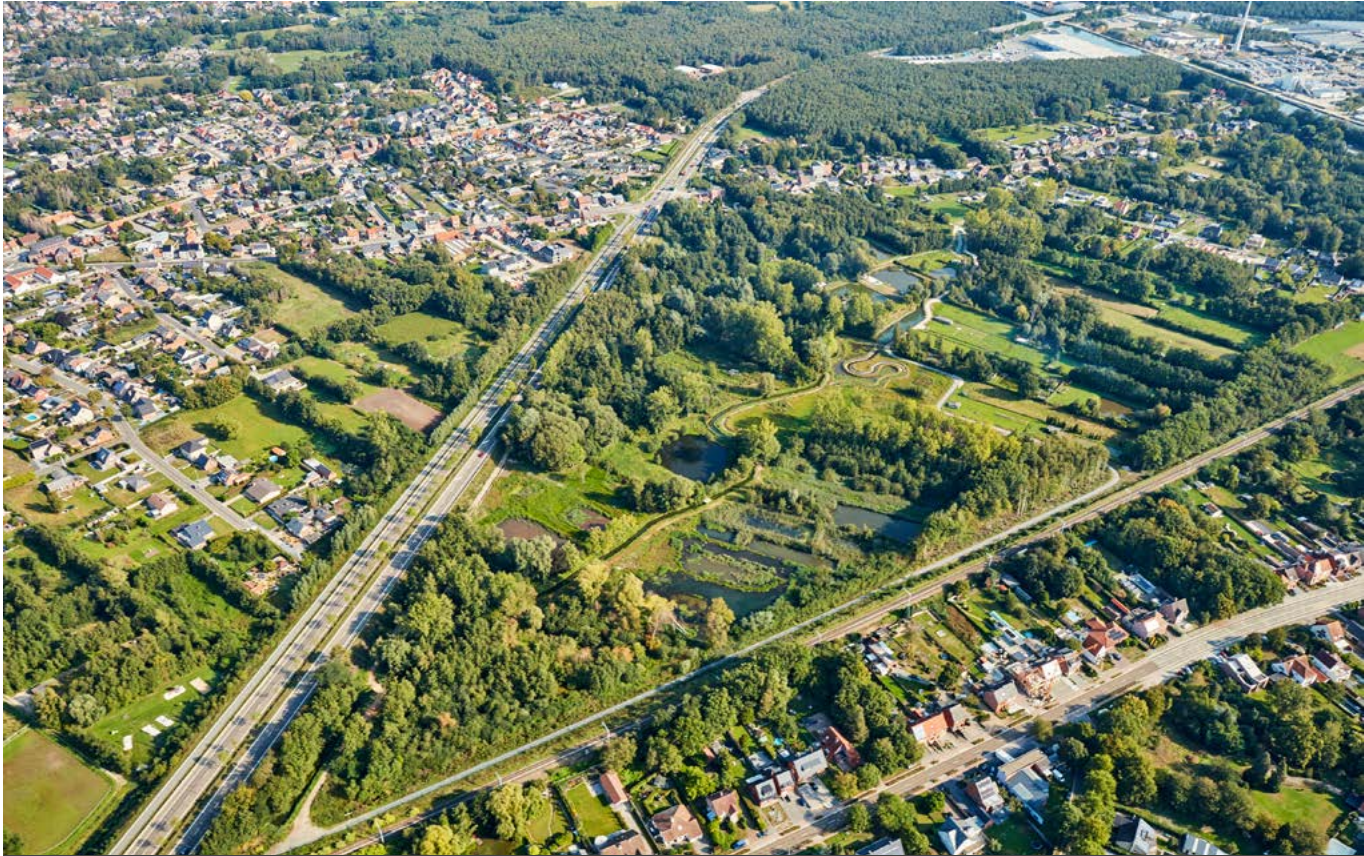
Herstel overstromingsvlakte in provincie Antwerpen, Site Gompels Broek
