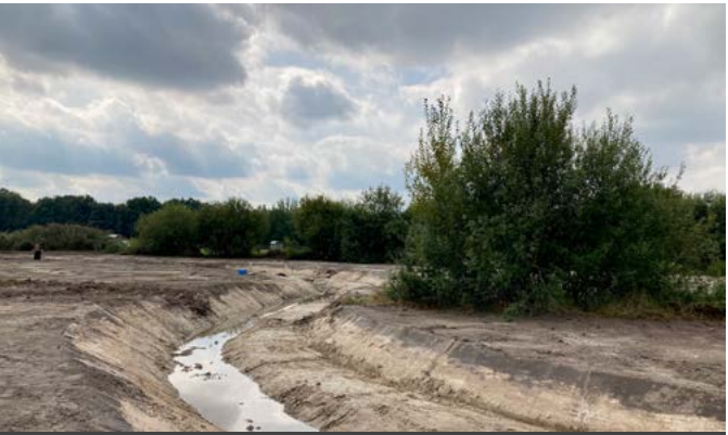
© Leo Santbergen - Herstelwerken voor meanderende beken in Nederland door Waterschap Brabantse Delta, Site De Vloeiweide
