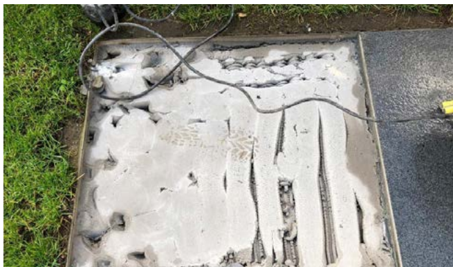
Er werd heel wat restvocht aangetroffen onder de tegel. Holtes in de mortelspecie kunnen voor condens en dampdruk zorgen met onthechting tot gevolg
