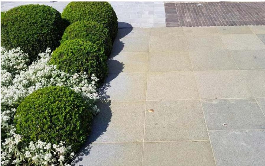
Meststoffen die ijzer bevatten kleuren de natuursteen tegels - deze oppervlakkige vervuiling is makkelijk te verwijderen met een roestomzetter.
