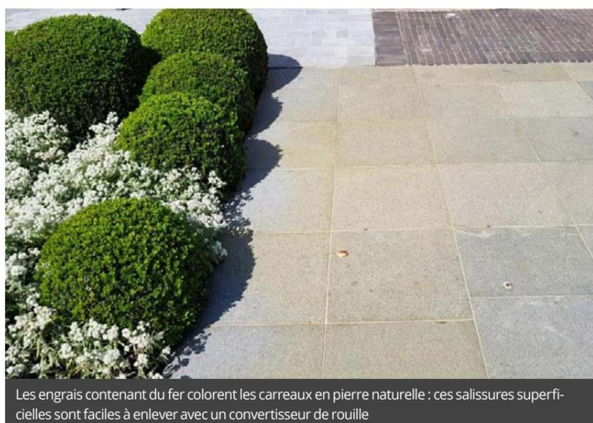
Les engrais contenant du fer colorent les carreaux en pierre naturelle : ces salissures superficielles sont faciles à enlever avec un convertisseur de rouille
