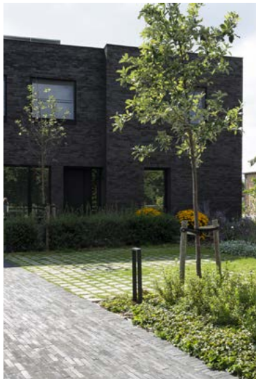
Parking met betonstraatstenen 15 op 15 cm en 2 cm brede grasvoeg en toegang in kleinklinker
