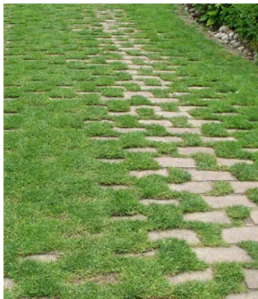
Voorbeeld van creatief omgaan met betonstraatstenen in combinatie met gras
