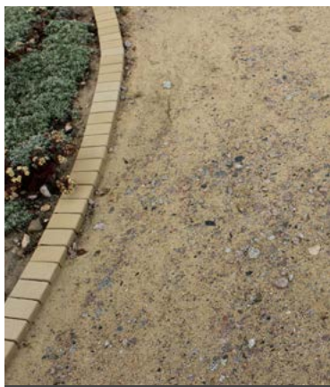
Onderlaag van verdicht steenslag voor afwerking met kiezellaa
